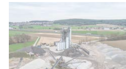
Kies- und Asphaltmischwerk Asbach
