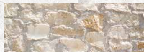
S30-04 Jura Kalkstein-Mauerwerk gealtert
