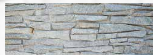
S30-19 Gneis-Bruchsteinmauerwerk grau
