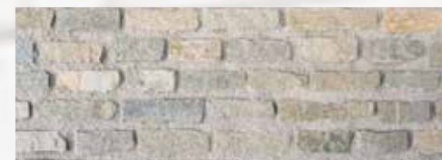
S30-16 Gneis-Bruchsteinmauerwerk graubraun
