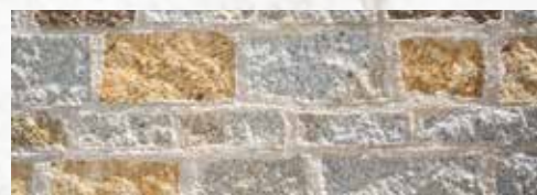
S30-02 Thansteiner Granitmauer
