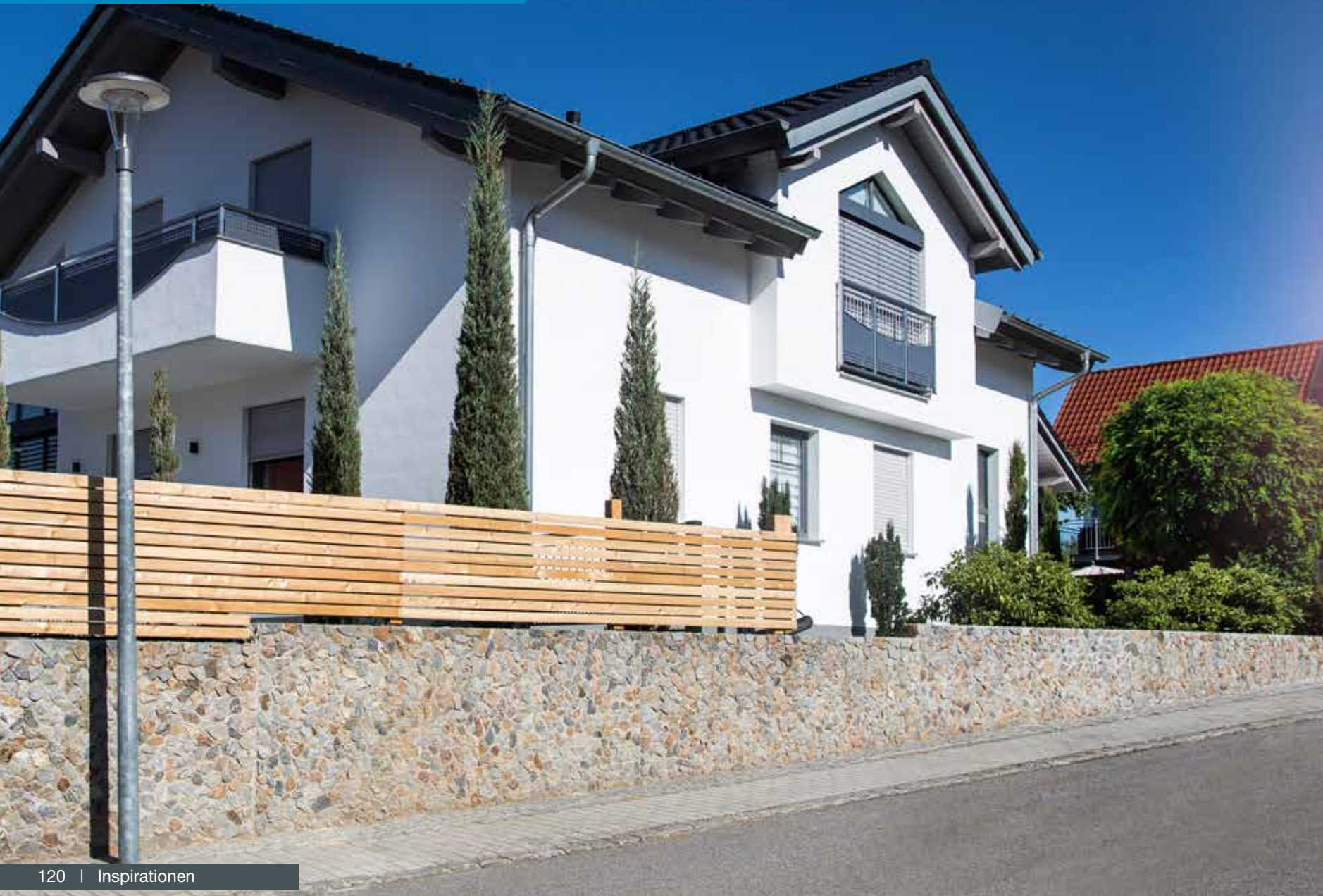
Starwalls Granit gebrochen
