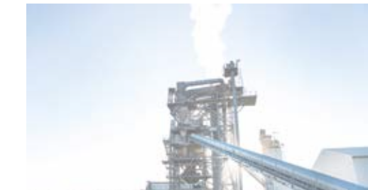
Schotter- und Asphaltmischwerk Winklarn
